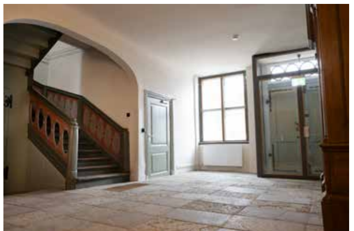
Von 1624: Nicht nur der Eingangsbereich wurde aufwendig saniert.
